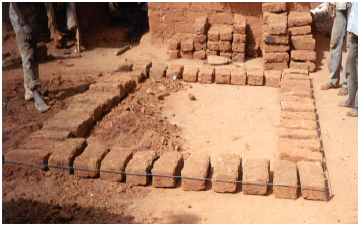
Disposition des premières briques après le tracé de la base
